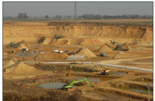
Carrière de sable pouvant accueillir une colonie d'hirondelles de rivage
