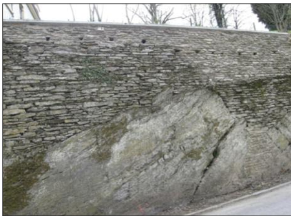
Vieux mur après restauration, les entrées des tunnels sont bien visibles dans la partie supérieure
