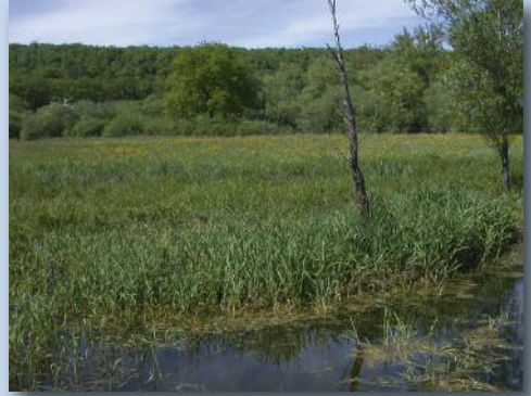
2. Réserve naturelle LRBPO, gérée par les CNB « Sous Saint-Roch » à Nismes, construction d'un observatoire ornithologique (photo B. Clesse)
