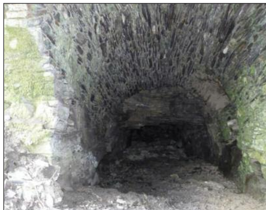
Galerie d'exploitation des schistes ardoisiers plongeant en suivant les bons bancs d'ardoise
